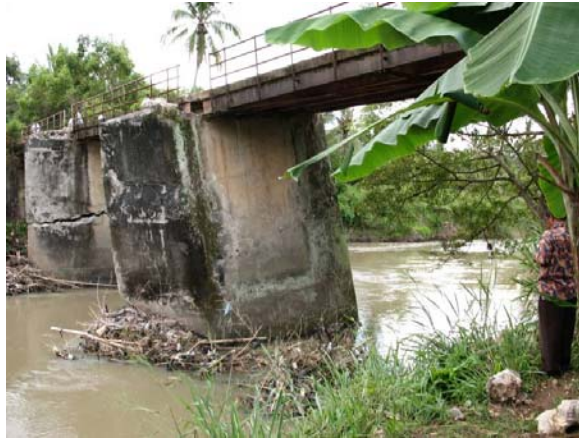
a. Rocking failure
