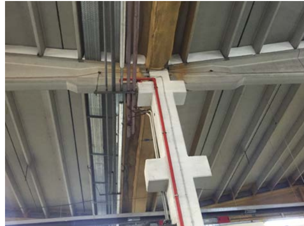
Şekil 1. Sanayi yapısı inşaat fazları (a) ve kolon-makas birleşimi (b)
